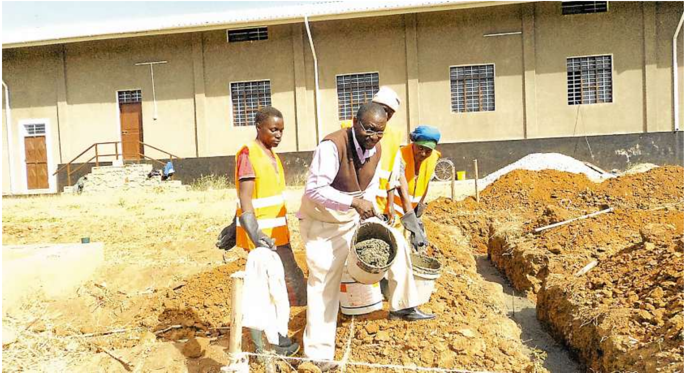
Die Mauerfundamente für das neue Küchegebäude der St.-Charles-Schule in Iringa/Tansania werden gegossen, die Afrika-Gruppe der früheren Lukas-Gemeinde hilft dabei finanziell wie schon beim Essraum im Hintergrund. Fotos: privat
